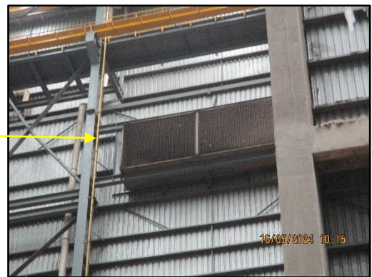
ภาพที่ 2.7 พัดลมดูดอากาศอาคารเก็บเชื้อเพลิง
