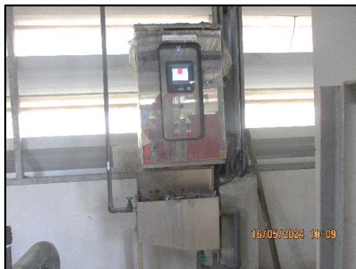
ภาพที่ 2.16 เครื่องตรวจวัดน้ำอัตโนมัติแบบต่อเนื่อง และหน้าจอแสดงผล
