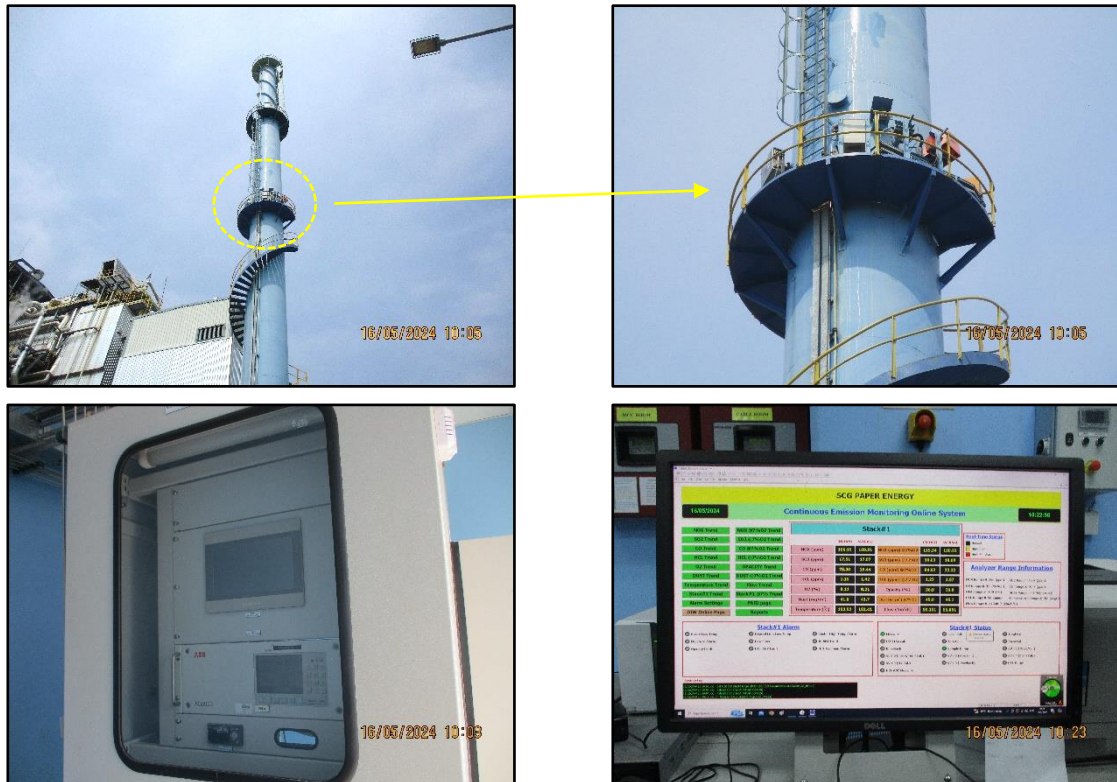
ภาพที่ 2.4 เครื่องตรวจวัดคุณภาพอากาศจากปล่องแบบต่อเนื่อง (CEMs)
