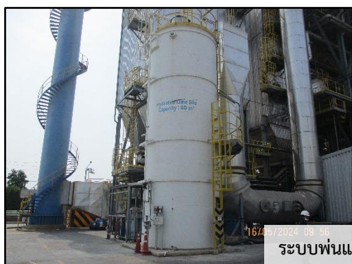
ภาพที่ 2.1 ระบบ flue gas treatment
