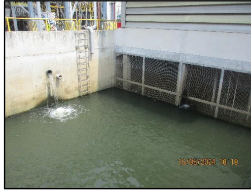
ภาพที่ 2.13 บ่อพักน้ำทิ้ง (Holding pond) ขนาด 600 ลูกบาศก์เมตร
