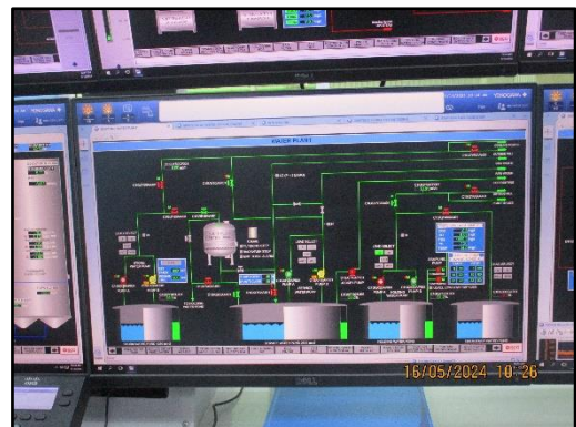
ภาพที่ 2.16 เครื่องตรวจวัดน้ำอัตโนมัติแบบต่อเนื่อง และหน้าจอแสดงผล
