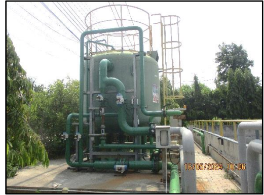
ภาพที่ 2.20 บ่อน้ำฝน (Storm Water Pond) และระบบกรองทราย
