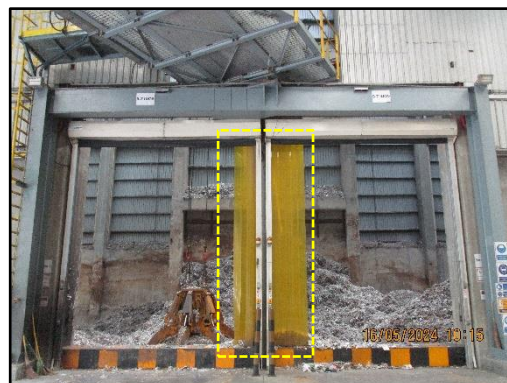
ภาพที่ 2.12 แผ่นม่านประตูภายในอาคารเก็บเชื้อเพลิง
